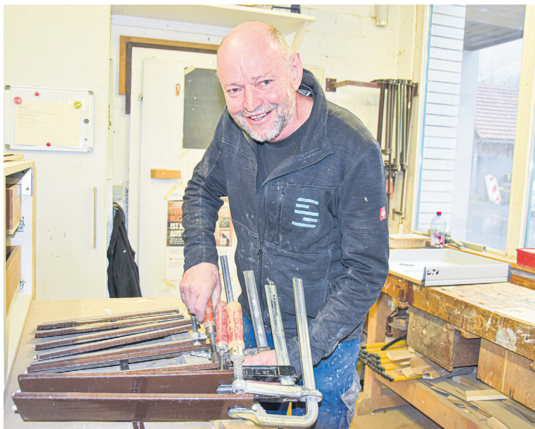
Markus Ochsner beim Reparieren von Lamellen eines Holzfensterladens.
